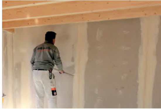
Gipskartonplatten mit IR-Heizgewebe – nach der Anlieferung und beim Einbau.
