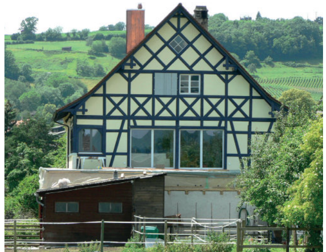
Die neu geschaffenen Fensteröffnungen werden in die bestehende Struktur eingepasst.
