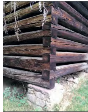
Schräge Eck-Kämme im Blockbau.
