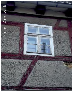
Getrennte Diagonalen sollten im Rahmen der Sanierung in den Urzustand zurückgeführt werden.
