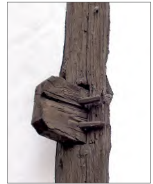
Durchgeschossener Zapfen mit Sicherung durch Holznägel.
