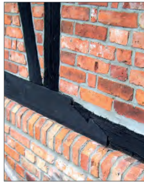
Schräges Hakenblatt als zugfeste Verbindung.
