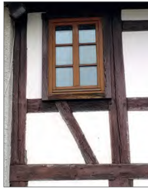
Getrennte Diagonalen sollten im Rahmen der Sanierung in den Urzustand zurückgeführt werden.
