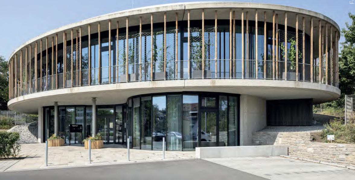
Die Umweltstation Würzburg wurde aus 650 m<sup>3</sup> Recyclingbeton hergestellt – der Rohstoff stammte von einer baufälligen Autobahnbrücke in der Nähe.
