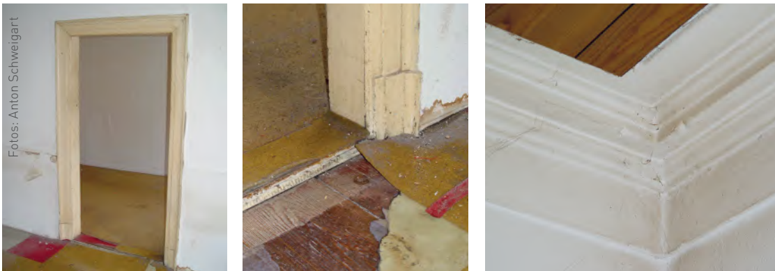
Auszug aus einer Bestandsdokumentation; von links nach rechts: historische Türeinfassung (Foto 1), Fußpunkt (Foto 2), Raumecke mit Stuckdetail (Foto 3). Die Fotostandorte sind in nebenstehendem Grundriss gekennzeichnet.
