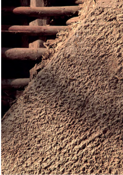
Das Prinzip der Fachung mit Flechtwerk und eine Sanierung mit Stakung und Strohlehm.
