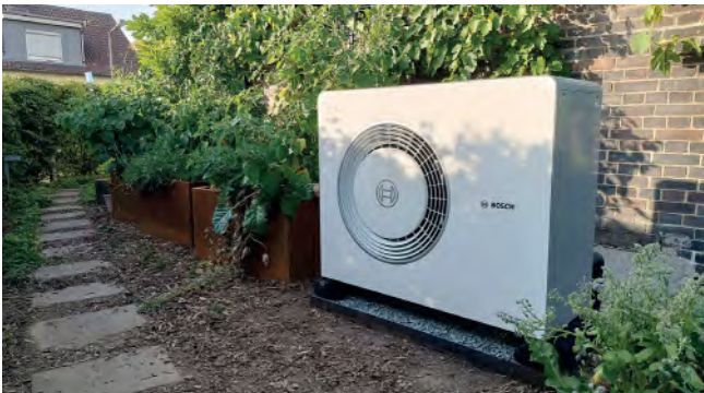
Beispiel für eine Luft-Wasser-Wärmepumpe mit Speicher (rechts).
