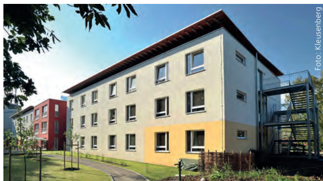
Aus vorgefertigten Stahlrahmenmodulen besteht dieses Passivhaus-Pflegeheim in Mönchengladbach.
